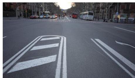
Intersección mal señalizada. La vía ciclista simplemente desaparece en la intersección.
